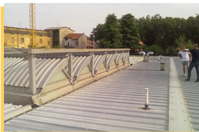
Efficientamento energetico mensa scolastica
